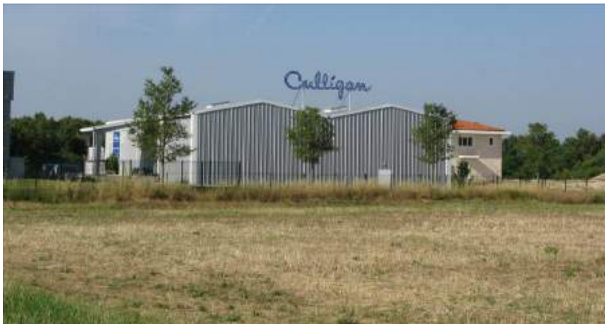
Figure 58 : Zone d'activité de la Pile - Source : Ingérop Conseil et Ingénierie
