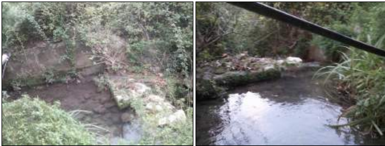
Figure 26 : Seuil sur le Budéou en aval de la RD572 : INGEROP, 09/2012)
