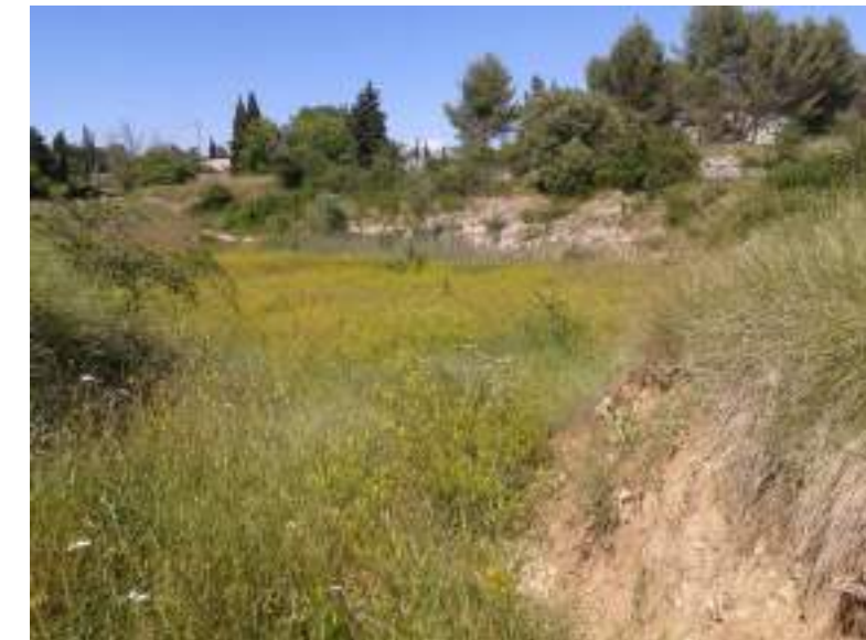
Figure 37 : Photographie du bassin de rétention du Deven
